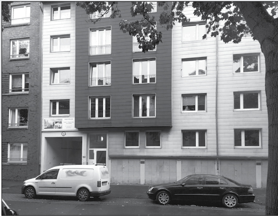
So sieht's aktuell auf der Bankstraße 7-11 aus.
